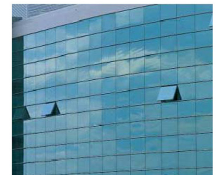
EJEMPLO DE MURO CORTINA DE VIDRIO
