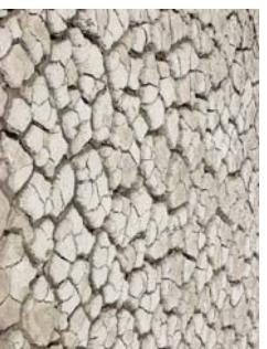
SITUACIÓ ACTUAL (coberta de plaques alveolars)
