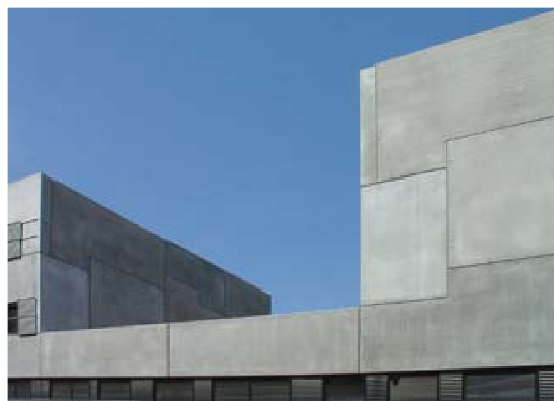
Pieza prefabricada de "GRC" panel strud-frame color beis grisáceo, piezas de hasta 30 m2 con una medida limitada a 4 m.
