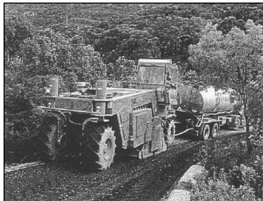
Foto 2.2. Equipo WR-2500 trabajando en carretera (Fuente: Revista Carreteras)
