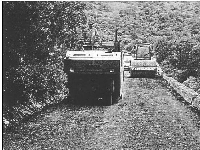
Foto 2.4. Equipos de compactación de una capa reciclada (Fuente: Revista Carreteras)
