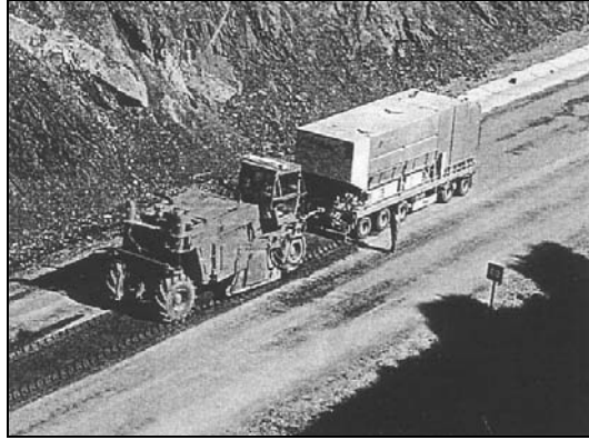
Foto 2.3. Vista de un equipo mezclador WM 1000 delante de una WR-2500 (Fuente: Revista Carreteras)
