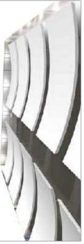
Paleta de fang i sorra reforçat amb un absorvent acústic de 20 mm de gruix 125 kg/m<sup>3</sup> i un vidre de vidre reflectant a una cara
