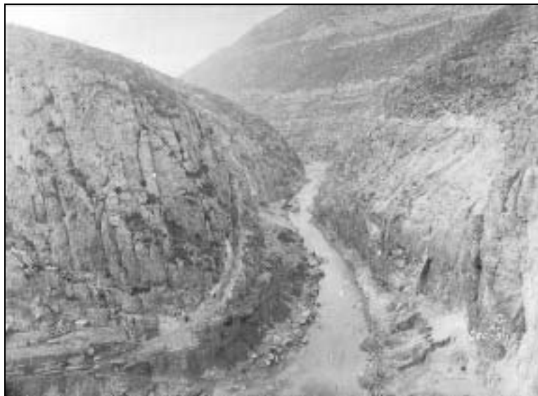
Foto 6: Panorámica del emplazamiento de la presa visto desde aguas abajo. Se aprecian los trabajos de excavación del funicular en el margen derecho del Noguera.
