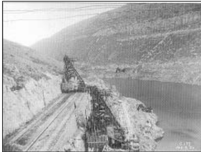
Foto 9: Esta foto muestra la instalación de las torres de los blondines del margen derecho de la Noguera.
