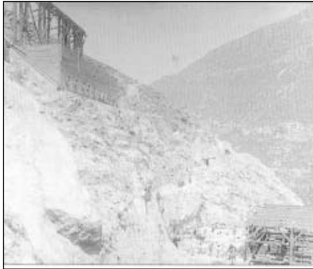
Foto 7:: 4 de julio de 1918; Se está trabajando en la construcción de las instalaciones de hormigonado. En la parte superior la fábrica de cemento y en la inferior la tritadora.
