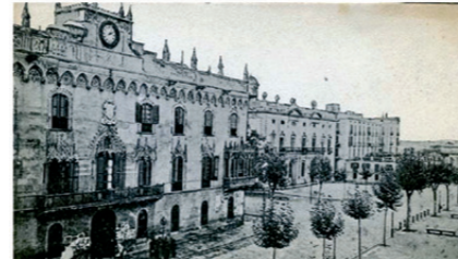
EDIFICI DE LA NOVA DUANA (1790 - 1792)
