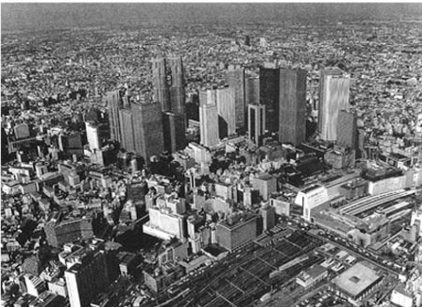
La construcción del centro direccional de Shinjuku.
