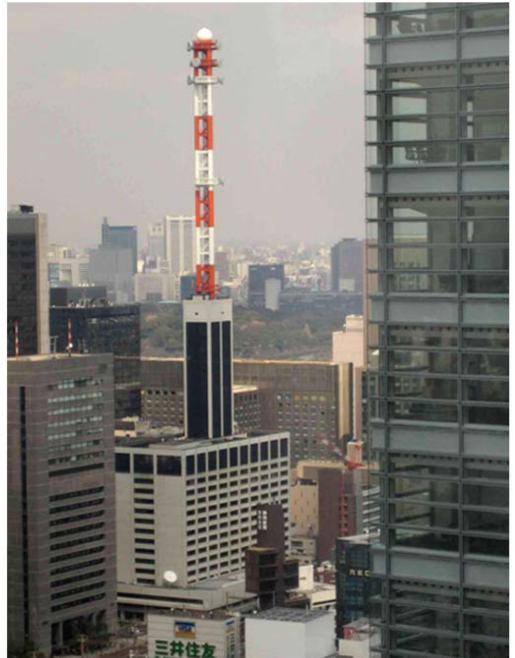
Un repetidor en la zona de Ginza. De bajo el Shizuoka Building de Kenzo Tange alto más de 60m.
