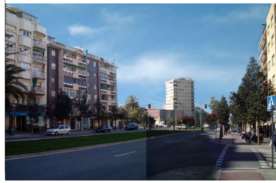
Vista des de la carretera de Cornellà
