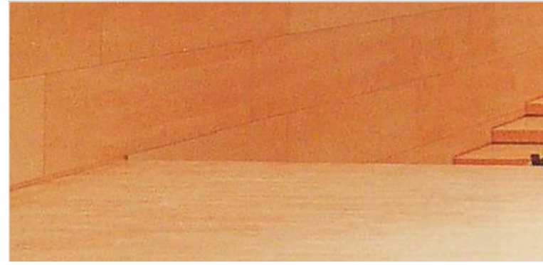
Paviment de fusta de la sala de conferències, parquet e: 3cm enganxat amb cola de poliuretà.
