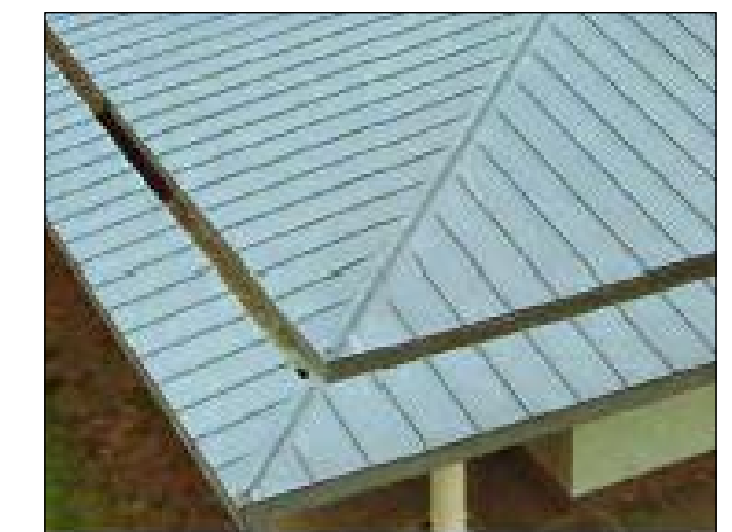
Coberta de xapa plegada acer, pesa de remat, espessor 1 mm.
