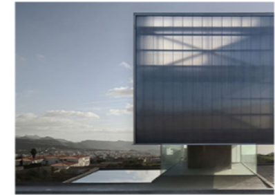
tancaments de policarbonat translúcid PANELPIÙ 500/40 CRIPLAST TIPUS_x4 cambres COLOR_translúcid U TERMICA_0,82W/m²K
