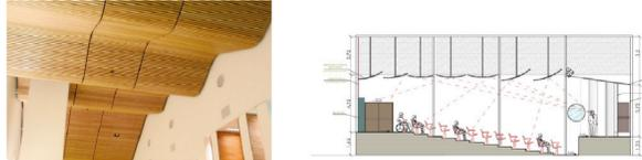
El auditorio se configura con un falso techo distinto al resto del edificio. Mediante lamas de madera que generan superficies curvas se cubre todo el perímetro, este tipo de falso techo permite la colocación de luminarias e instalación climática de una manera sencilla además de ayudar a conseguir una acústica adecuada.
