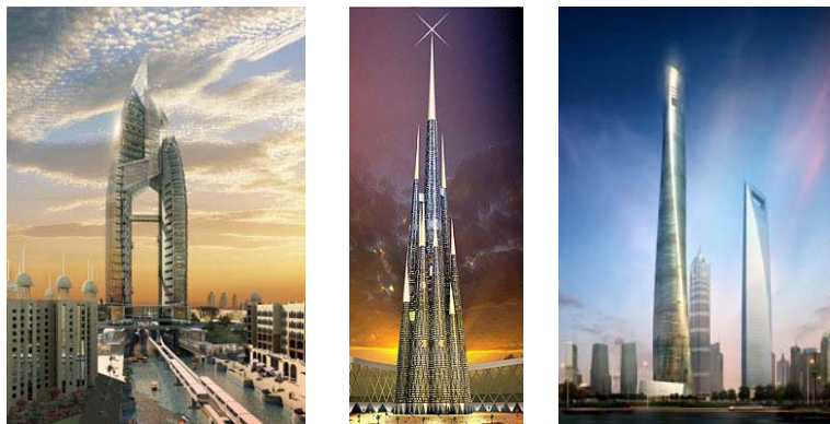
Fig. 1: Proyectos “icónicos”: Trump Tower en Dubai, Torre de Noida en Nueva Delhi, Shanghai Center Dragon en Shanghai
