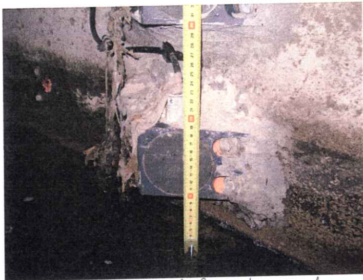
Foto 9 caudalímetro inferior Mirando al mar lado izquierdo 14 cm. desde solera al eje del sensor.
