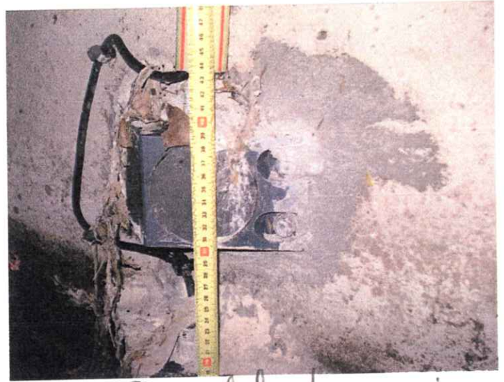
Foto 10 caudalímetro Superior Mirando al mar lado izquierdo 34,5 cm. desde solera al eje del sensor.
