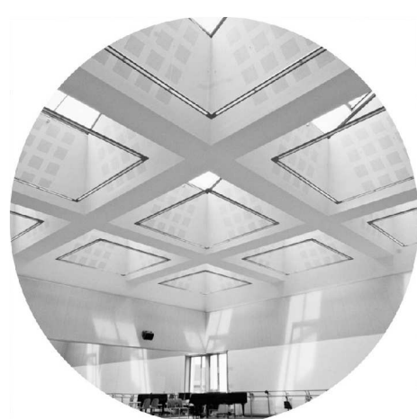
Il·luminació indirecta amb estructures penjades de lluminàries
