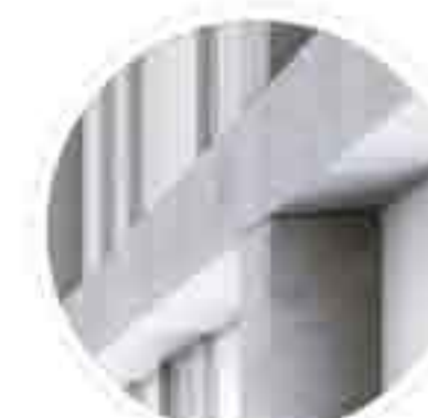
Estructura de formigó vist (pilars i jasseres)
