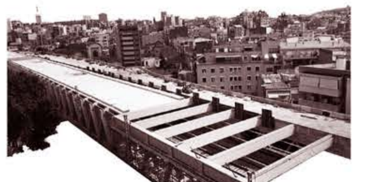
9. Cobriment vies ferroviàries Prolongació estació de Sants
