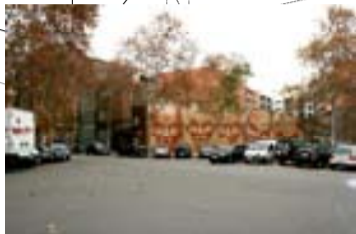
F3 / façana sud, rambla carrer Hondures i carrer J. Estivill
