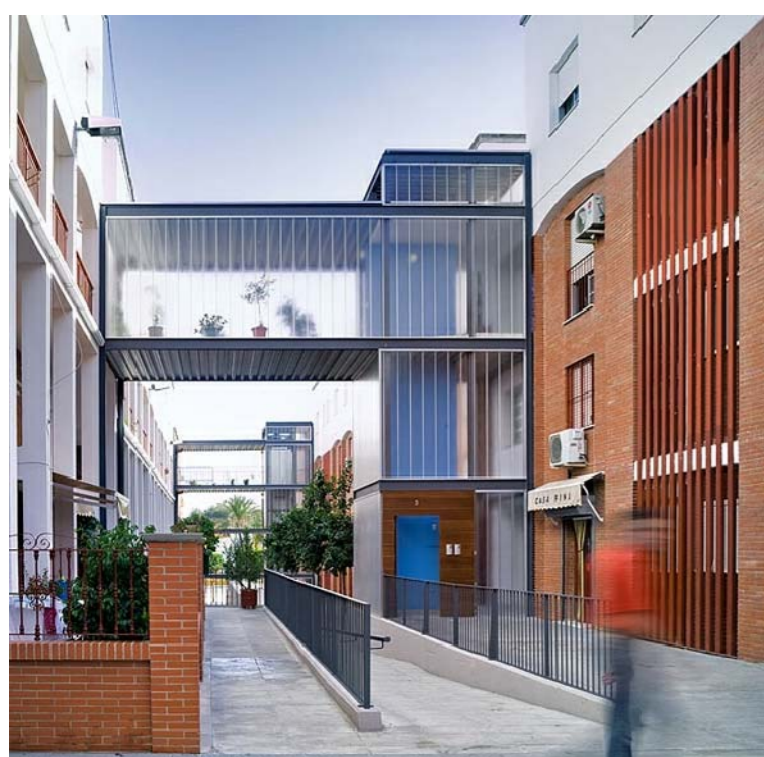
Intervenció espais comuns, Sevilla, AF6 Arquitectes
