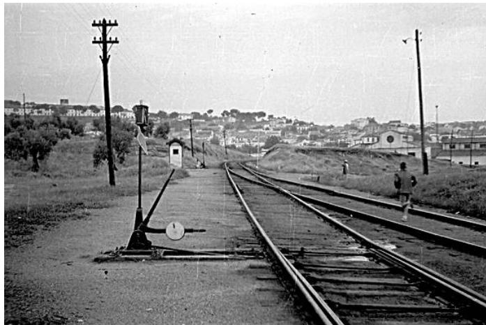
Fig. 2 Antiguo cambio de agujas con accionamiento manual mediante marmita.
