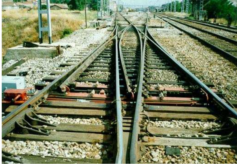
Fig. 52 Instalación en campo de un accionamiento eléctrico de agujas.
