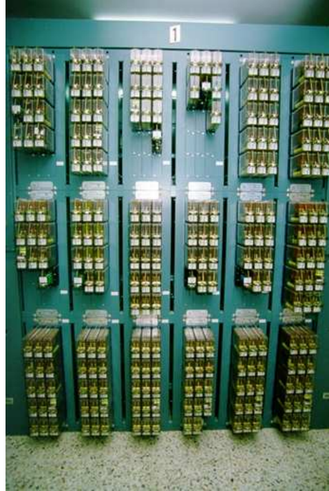
Fig. 62 enclavamiento eléctrico geográfico o modular.
