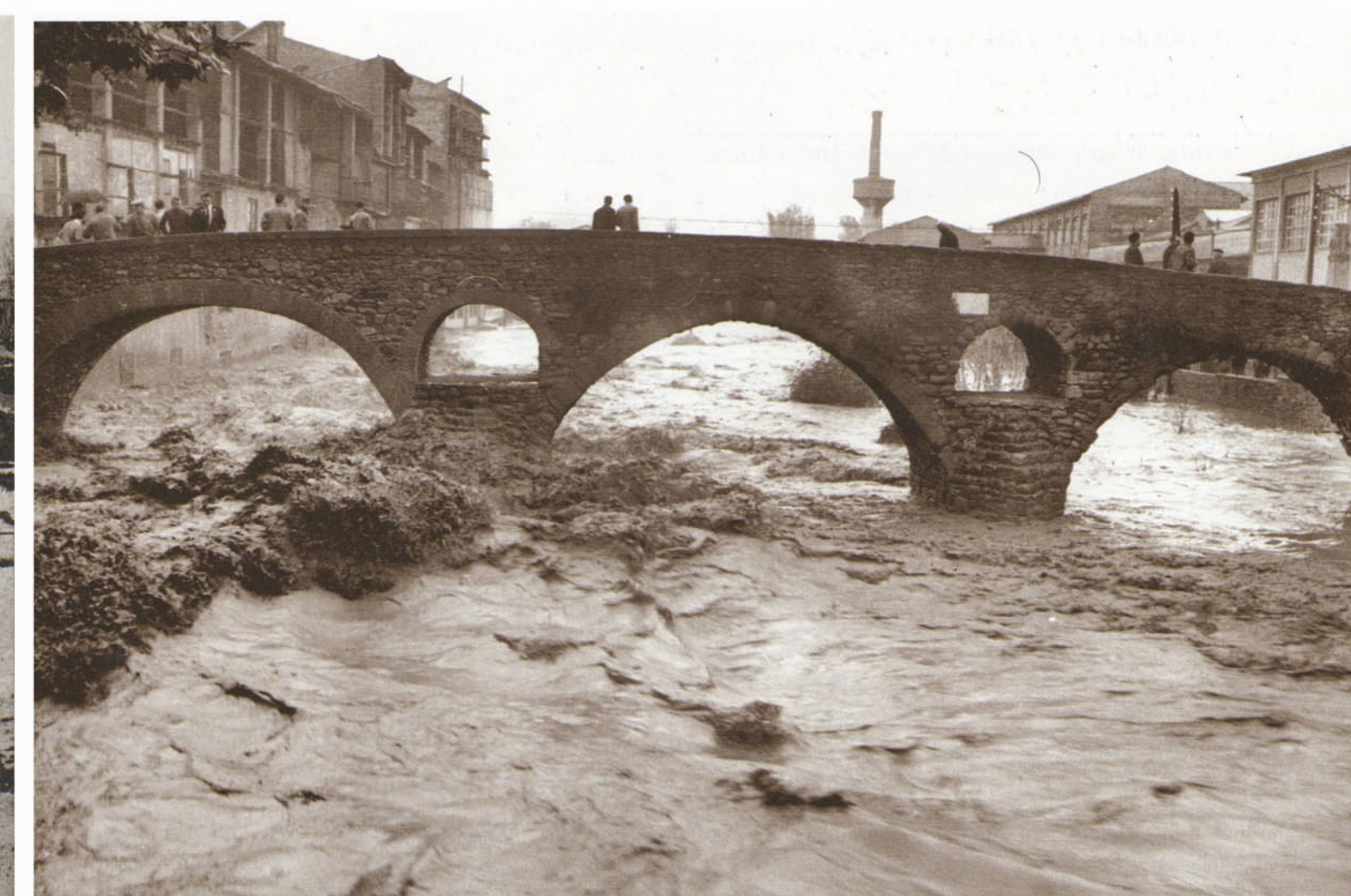
Forts aiguats del 1962. Fotografia del riu Mèder al seu pas per les Adoberies. Això va fer prevenir posteriorment les Adoberies de la inundabilitat amb comportes metàl·liques al soterrani.
