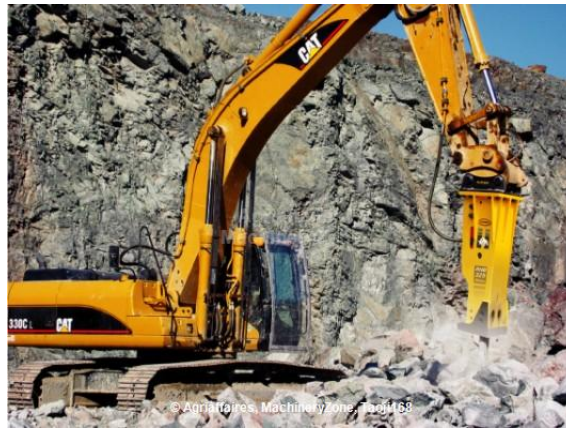
Figura 31: Máquina excavadora con martillo hidráulico. Fuente[R]
