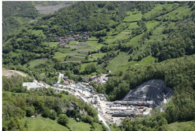
Figura 13: Túnel Pajares, boca norte Fuente: [31]
