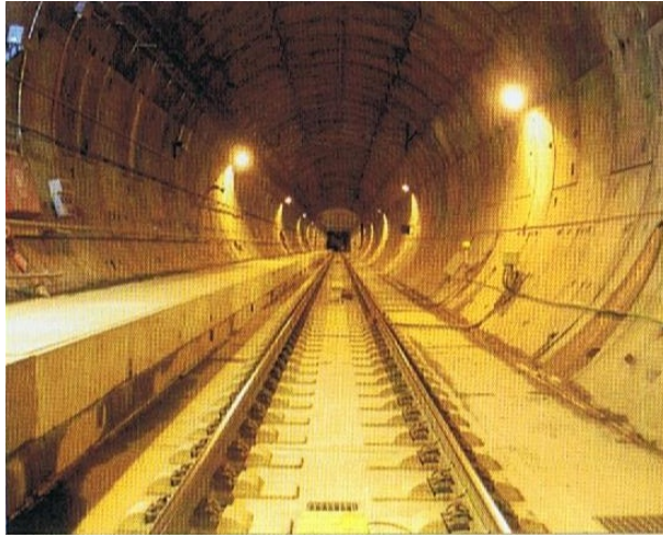
(a) Vía en placa RHEDA 2000 en los túneles de Guadarrama. Fuente:[1]
