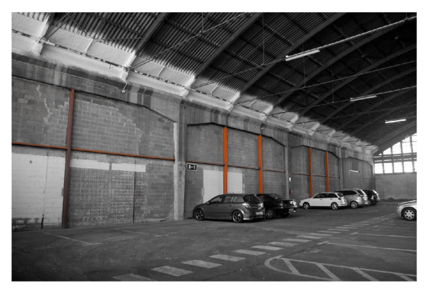
IMG 4: Les separacions que s'han fet a l'interior comencen a tenir patologies i s'han hagut d'apuntalar. Seria convenient retirar-les i construir uns nous paraments.
