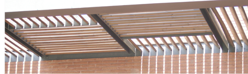
Detall. Pergola de fusta. Àtic duplex.
