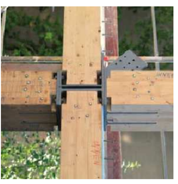
UNIO DE PILARS I JASSERES
