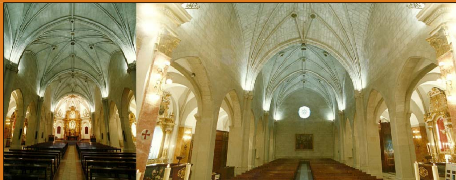
II.luminacio Esglesia Sant Sever. Potenciar les línies barroques. Els arcs, pilastres. II.luminacio calida
