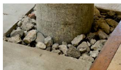
arid rodat recuperat de l'extracció d'enderroc protecció d'elements de valor
