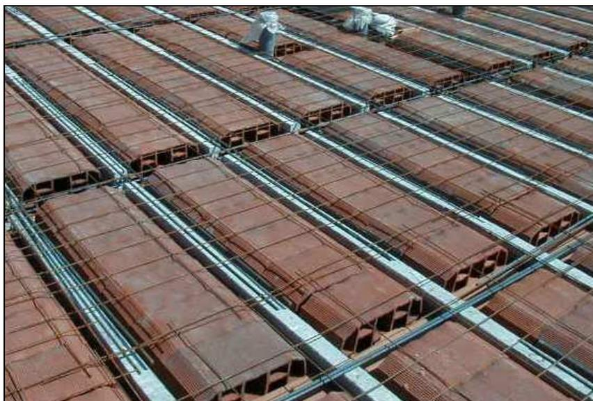
**Figura 2.1. Forjado unidireccional semiprefabricado**
