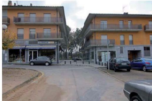
3 VISTA DE L PARC DE LA SARDANA DES DE LA PLAÇA
