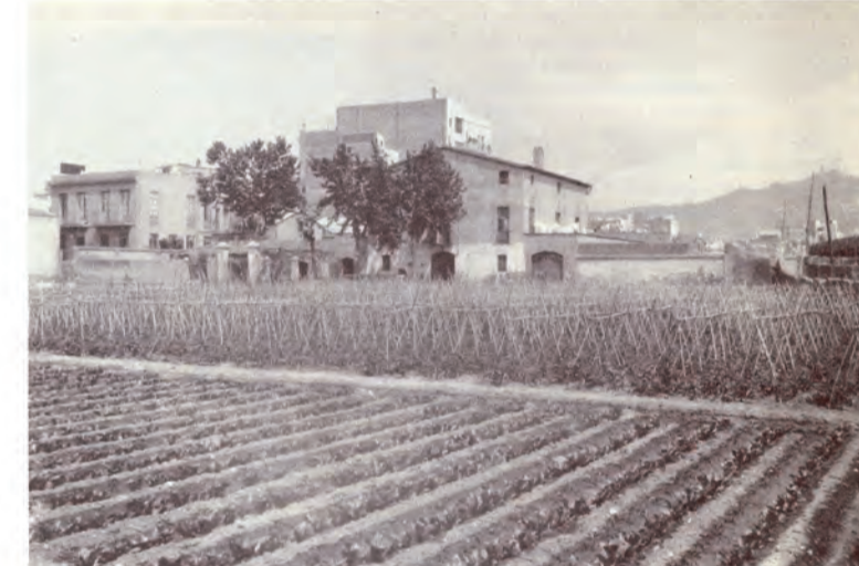
1931. La masia de Can Mantega. Es comença a construir al voltant dels terrenys de la masia.
