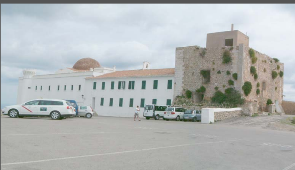
ESTAT ACTUAL DE LA EXPLANADA D'APARCAMENT
