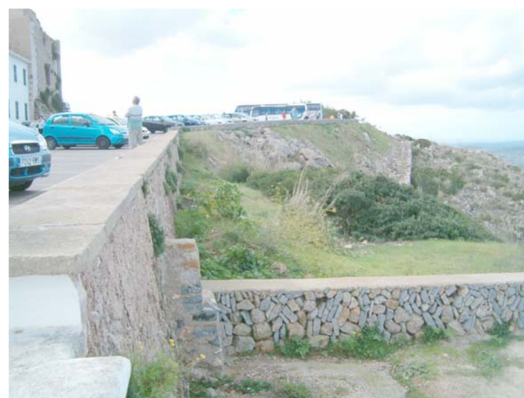
2. VISTA GENERAL DEL TALÚS ARTIFICIAL DE RUNES
