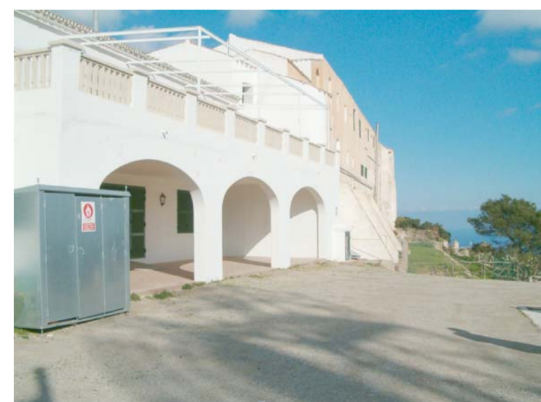
3 - TERRASSA I PORXADA DEL RESTAURANT
