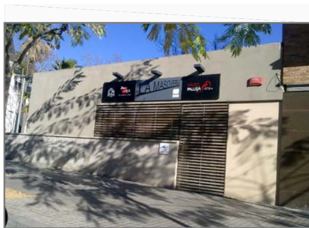
FOTOGRAFIA EXTERIOR. EDIFICI PRINCIPAL I ANNEX.
