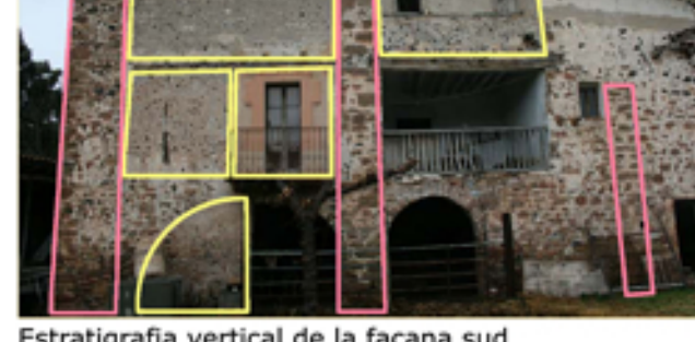
Estratigrafia vertical de la façana sud
