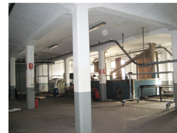
H=4,7m Estructura de formigó armat amb jàsseres acartellades Forjats ceràmics de volta d'arc rebaixat
