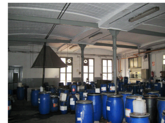
H=4,7m Estructura a base d'arcs rebaixats ceràmics i pilars de forja Forjats ceràmics de volta d'arc rebaixat S'incorporen tirants per controlar l'arc de descàrrega
