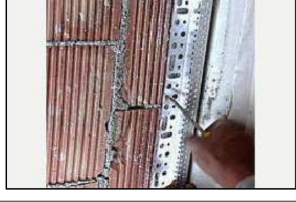
Col·locació malla, casa TEXSA
