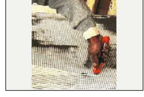
Col·locació malla, casa TEXSA
