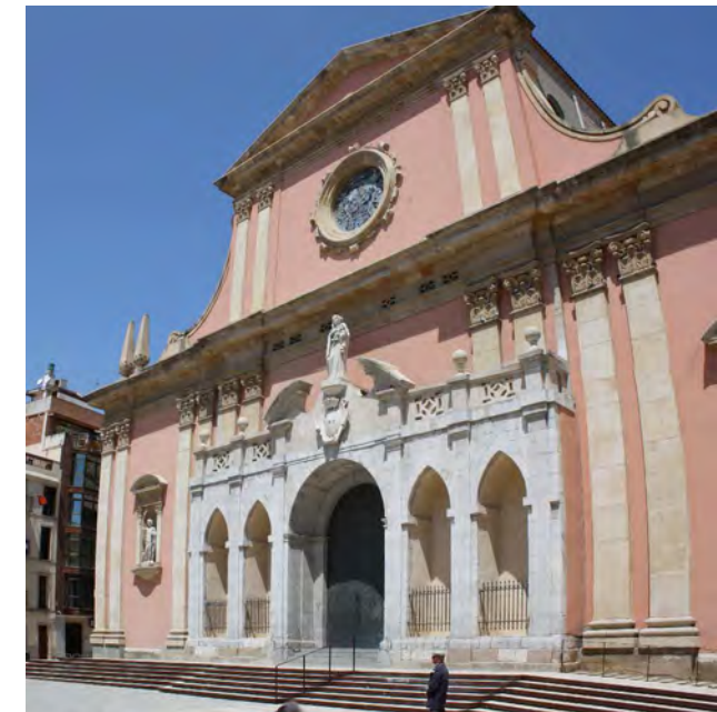
Imagen general fachada
