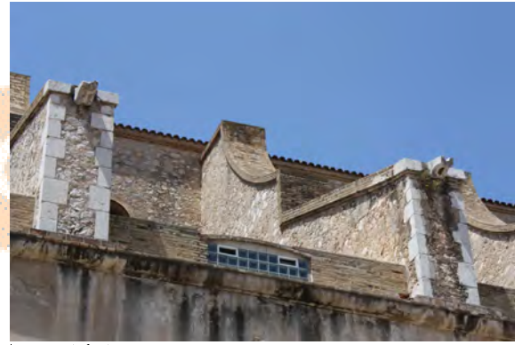
Imagen contrafuertes
