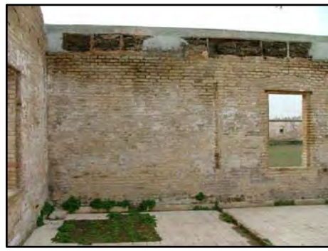
F-1 HUMEDADES POR CAPILARIDAD EN FACHADA: Afectan a las zonas bajas de la fachada aproximadamente entre 0.50 y 1 m. de altura. FF-1 Descomposición y degradación progresiva de la pared.
