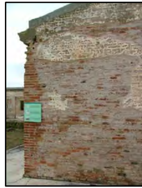
F-3 FF-3 EROSIÓN EN FACHADA: Abrasión o desgaste superficial producido por la lluvia y el viento. Provocan pérdida de sección y originan una pérdida de capacidad portante.
