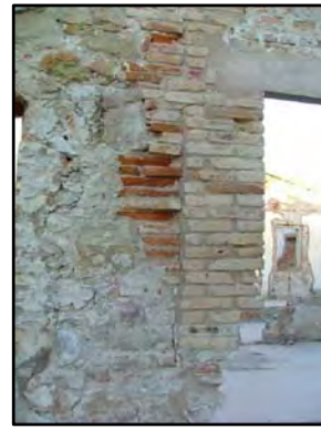
F - 2 FF - 2 FISURAS Y GRIETAS EN FACHADA: Producidas por acciones mecánicas de origen estructural, como pueden ser los asentamientos, los desplazamientos de los cimientos, flechas de vigas y techos.
