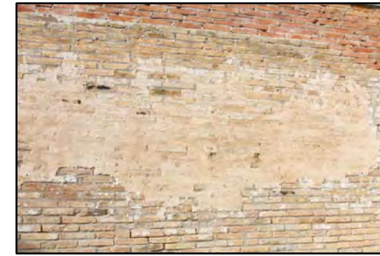
F-4 FF-4 DESPRENDIMIENTOS EN FACHADA: Del mortero de cal, producida por una falta de adherencia entre el revestimiento y el soporte, que puede ser causada por la presencia de sales, un defecto de ejecución o la degradación del material de soporte.
