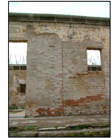
F-5 FF-5 MANCHAS Y EFLORESCENCIAS EN FACHADA: En los zócalos las manchas y eflorescencias tienen su inicio en la humedad por capilaridad. Las fachadas norte y este, están muy manchadas debido a la sombra y humedad que se genera en éstas.
