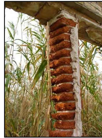
F-3 FF-3 EROSIÓN EN FACHADA: Abrasión o desgaste superficial producido por la lluvia y el viento. Provocan pérdida de sección y una pérdida de capacidad portante.
