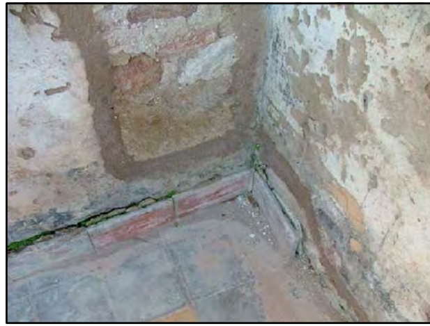
M-2 ENLUCIDO INTERIOR CON MORTERO DE CAL, PAVIMENTO DE BALDOSA CERÁMICA Y ZÓCALO DEL MISMO MATERIAL
