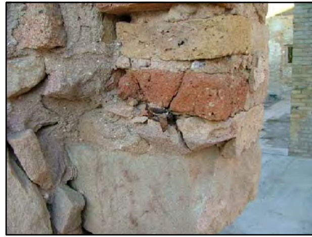
M-3 MURO DE PIEDRA ARENISCA TIPO MONTJUIC, CON TROZOS DE TOCHANA, ETC... ENLUCIDO CON MORTERO DE CAL
