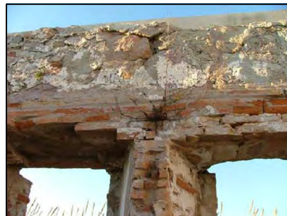
M-7 VENTANA CON DINTEL DE LADRILLO ROJO DE 29 x 14 x 4 cm, ANTEPECHO DE BALDOSA CERÁMICA
