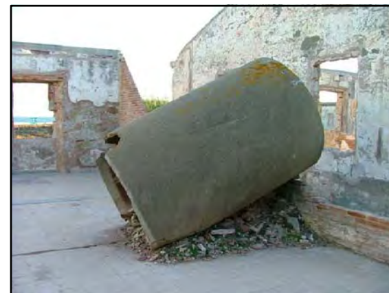
M-9 DEPÓSITO DE AGUA CILÍNDRICO DE HORMIGÓN, PARA ALMACENAR EL AGUA DE LA LLUVIA
