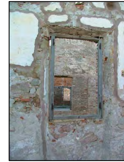
M-4 VENTANA CON DINTEL DE LADRILLO ROJO DE 29 x 14 x 4 cm, Y RESTOS DE CARPINTERÍA EXTERIOR
