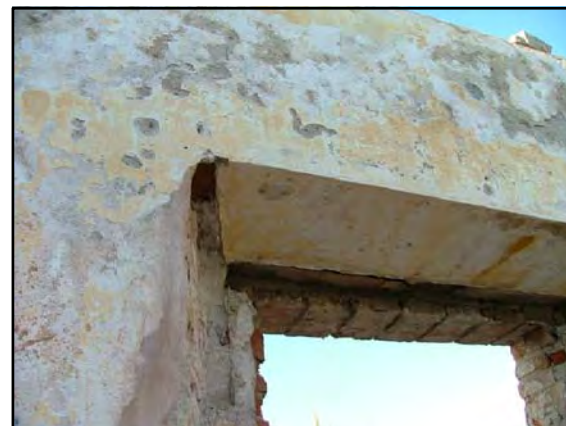
M-8 VENTANA CON DINTEL DE LADRILLO ROJO DE 29 x 14 x 4 cm, ANTEPECHO DE BALDOSA CERÁMICA, ENLUCIDO CON MORTERO DE CAL
