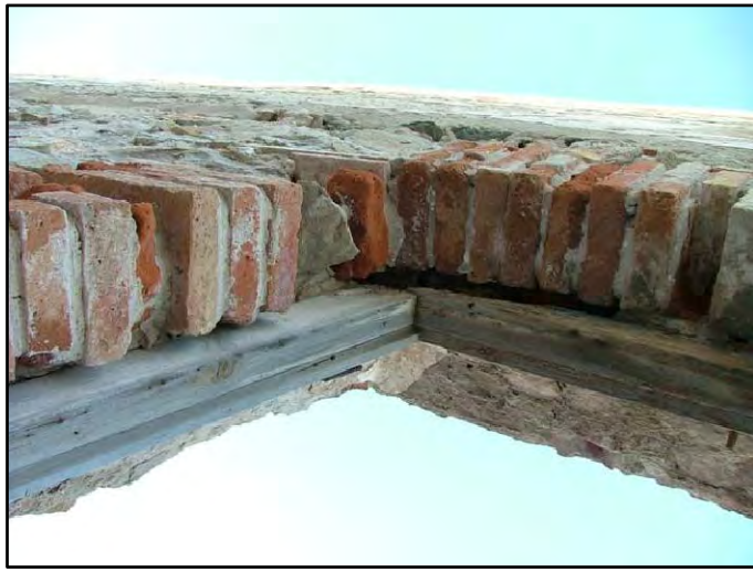
M-1 RESTOS DE LA CARPINTERÍA EXTERIOR DE MADERA, DE LOS HUECOS DE VENTANA
