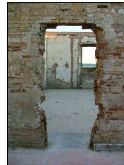
M-9 HUECO EN TABIQUERÍA INTERIOR, DE LAS ANTIGUAS PUERTAS
