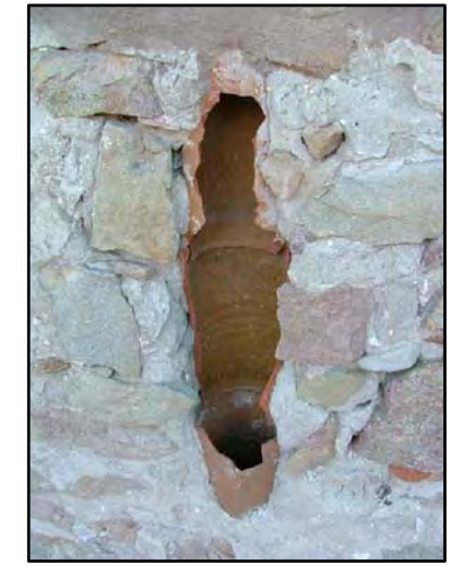
M-5 BAJANTE PLUVIAL DE CERÁMICA, ENCASTADO EN MURO DE PIEDRA EXTERIOR
