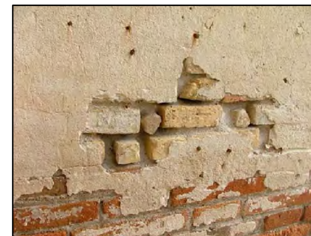
M-8 MURO DE LADRILLO DE MEDIA ASTA ENLUCIDO CON MORTERO DE CEMENTO PÓRTLAND PINTADO DE COLOR BLANCO
