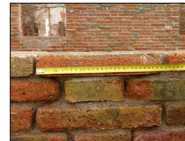
M-9 MURO DE LADRILLO DE MEDIA ASTA
