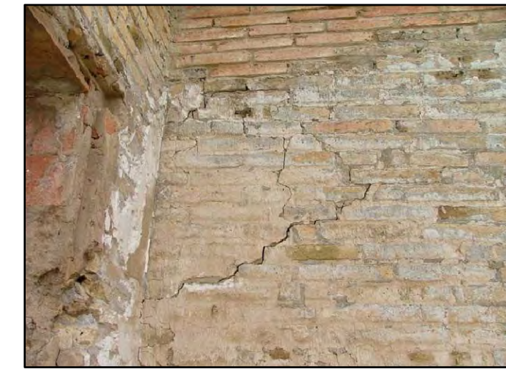
M-5 MURO DE LADRILLO DE MEDIA ASTA ENLUCIDO CON MORTERO DE CEMENTO PÓRTLAND PINTADO DE COLOR BLANCO
