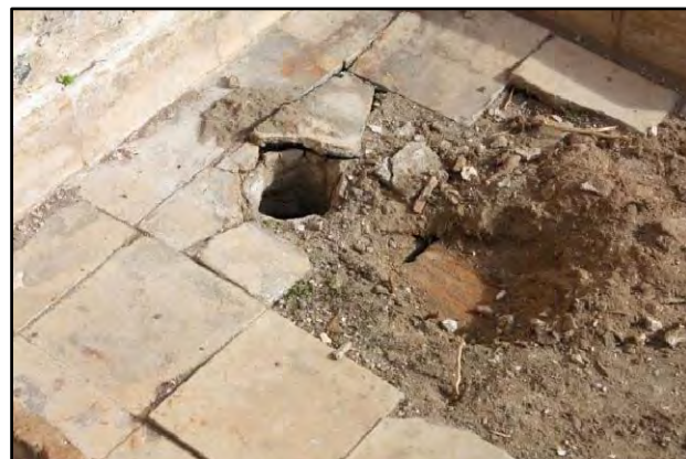
M-6 PAVIMENTO DE LOS BAÑOS DE TERRAZO DE 30 x 30 cm, CON SANEAMIENTO DE LOS ANTIGUOS INODOROS QUE DESAGUA EN LA FOSA SÉPTICA POSTERIOR
