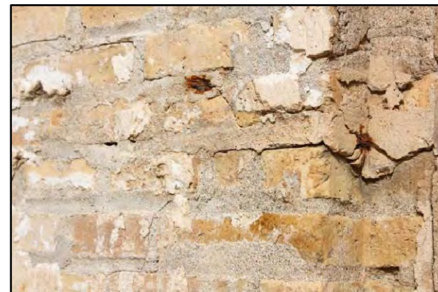
M-18 MURO DE LADRILLO DE MEDIA ASTA ENLUCIDO CON MORTERO DE CEMENTO PÓRTLAND PINTADO DE COLOR BLANCO
