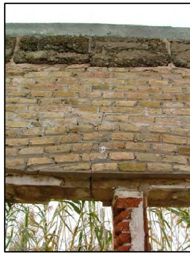
M-2 RELLENO DE LOS BLOQUES CON HORMIGÓN POBRE REALIZADO "IN SITU"
