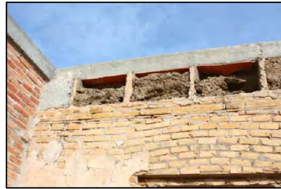
M-3 CORONAMIENTO DE LOS MUROS, RELLENO DE LOS BLOQUES CON HORMIGÓN POBRE REALIZADO "IN SITU" Y ZUNCHO PERÍMETRAL DE HORMIGÓN REALIZADO CON POSTERIORIDAD
