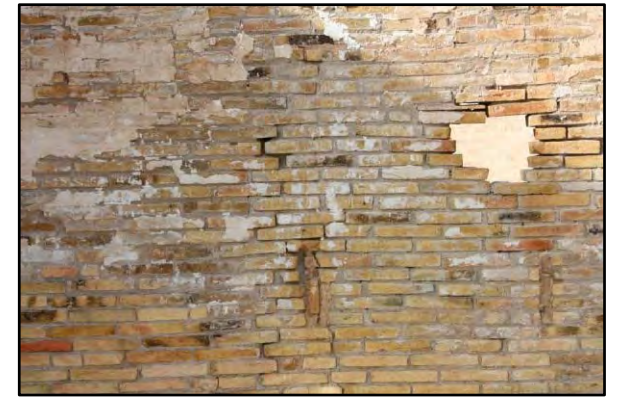
M-15 MURO DE LADRILLO DE MEDIA ASTA ENLUCIDO CON MORTERO DE CEMENTO PÓRTLAND PINTADO DE COLOR BLANCO
