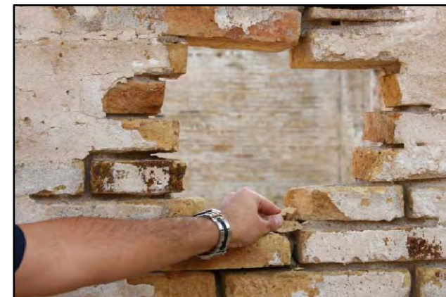
M-19 MURO DE LADRILLO DE MEDIA ASTA ENLUCIDO CON MORTERO DE CEMENTO PÓRTLAND PINTADO DE COLOR BLANCO
