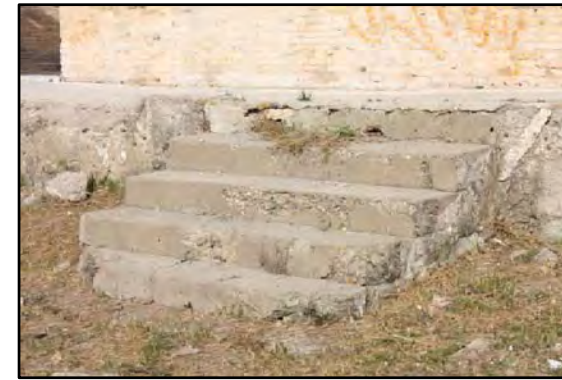
M-4 ESCALERA DE HORMIGÓN DE ACCESO AL ALA NORTE DESDE PATIO INTERIOR
