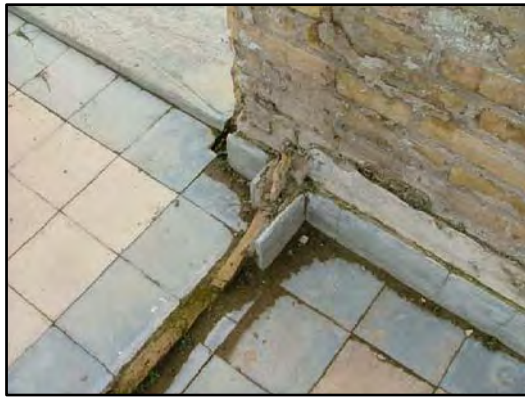
M-11 PAVIMENTO CERÁMICO DE TERRAZO DE 30 x 30 cm, DE DIFERENTES COLORES DEL INTERIOR DE LAS VIVIENDAS, Y JUNTA DE LA ANTIGUA PARTICIÓN DE DIVISIÓN DE LAS DIFERENTES ESTANCIAS
