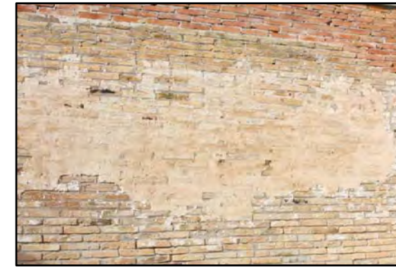
M-5 MURO DE LADRILLO DE MEDIA ASTA ENLUCIDO CON MORTERO DE CEMENTO PÓRTLAND PINTADO DE COLOR BLANCO
