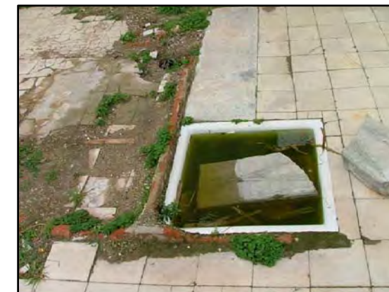
M-10 PLATO DE DUCHA DE PORCELANA, DE LA ZONA DE ASEOS. TABIQUERÍA INTERIOR DE LADRILLO CERÁMICO DE 5 cm DE ESPESOR. PAVIMENTO CERÁMICO DE 30x30 cm
