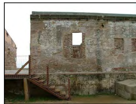
F3 - FOTOGRAFÍA CASA C - ALZADO OESTE
