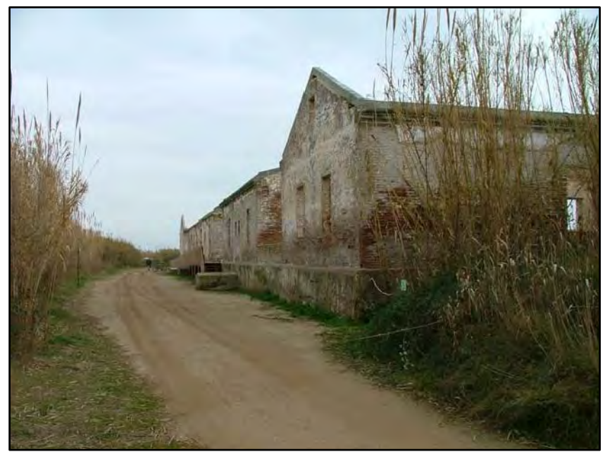
F2 - FOTOGRAFÍA ALA SUR - ALZADO OESTE
