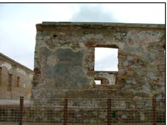
F5 - FOTOGRAFÍA CASA A - ALZADO OESTE
