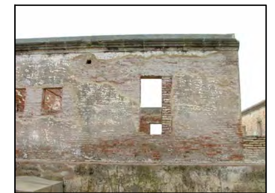
F5 - FOTOGRAFÍA CASA C - ALZADO OESTE
