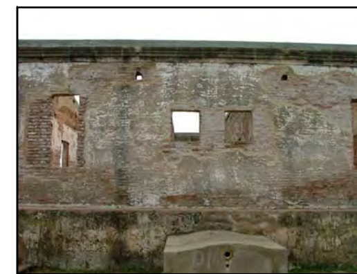
F4 - FOTOGRAFÍA CASA C - ALZADO OESTE
