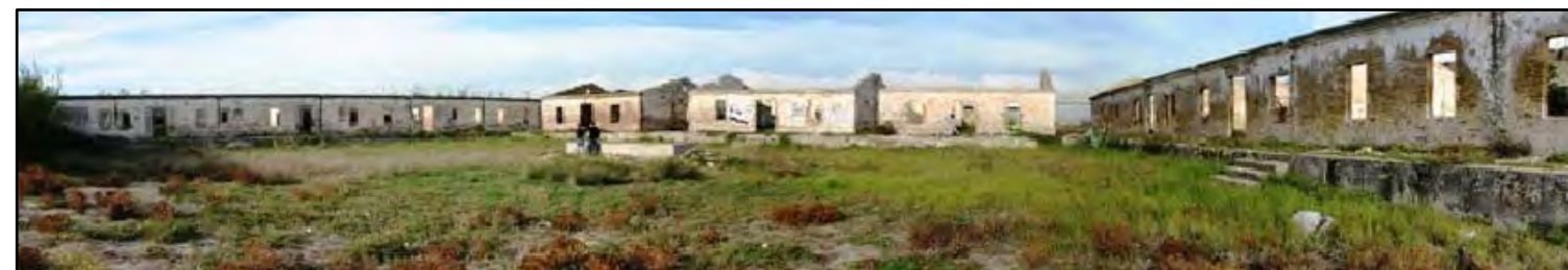
F1 - VISTA PANORÁMICA CASAS CENTRALES
